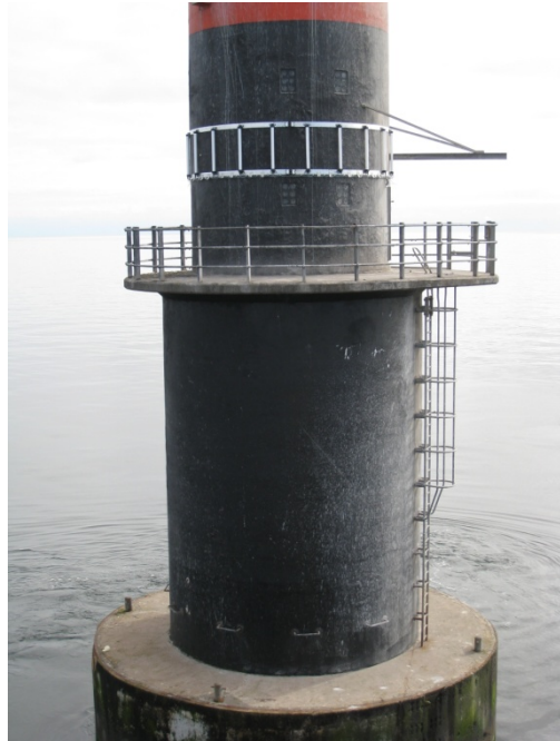
Figura 2 El Faro de Almgrund (Suecia) provisto de tubos LED
