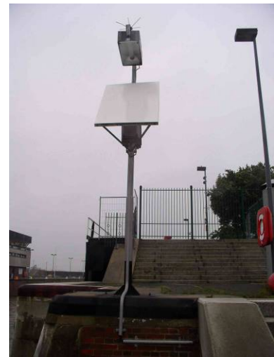
Figura 7 Tamaño del panel: 1050 x 760 mm: lámpara de sodio a baja presión de 90W.
