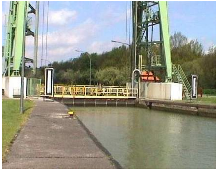
Figura 13 Se pueden ver a la izquierda y a la derecha de la compuerta de la esclusa unas ayudas a la navegación de entrada (Alemania).
