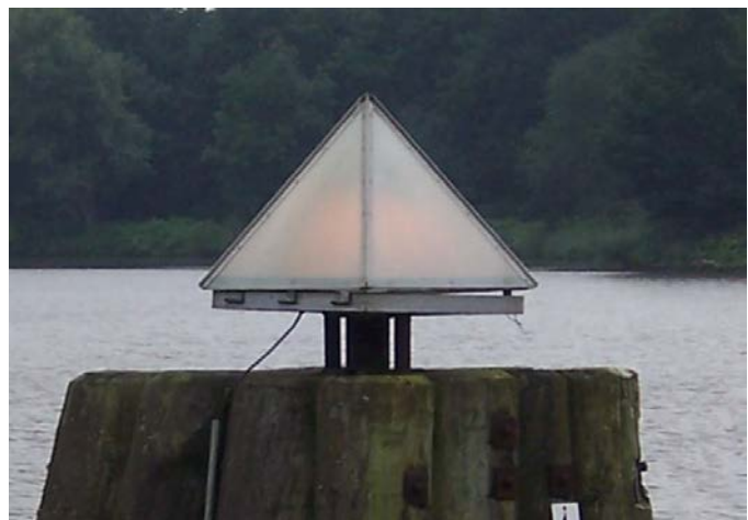
Figura 8 Una pirámide de acrílico iluminada desde el interior que señala un duque de alba.
