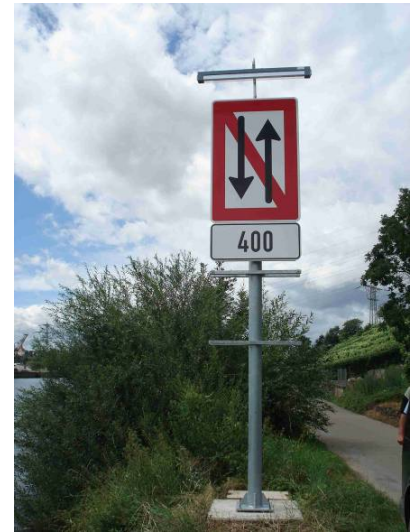
Figura 15 Señal típica con luminaria en la parte superior (Alemania).
